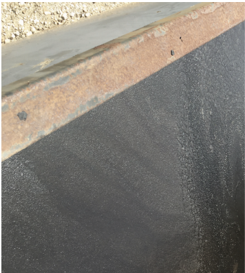
Barcaza de petróleo de 7.570.823 litros inundada con petróleo pesado y agua séptica
